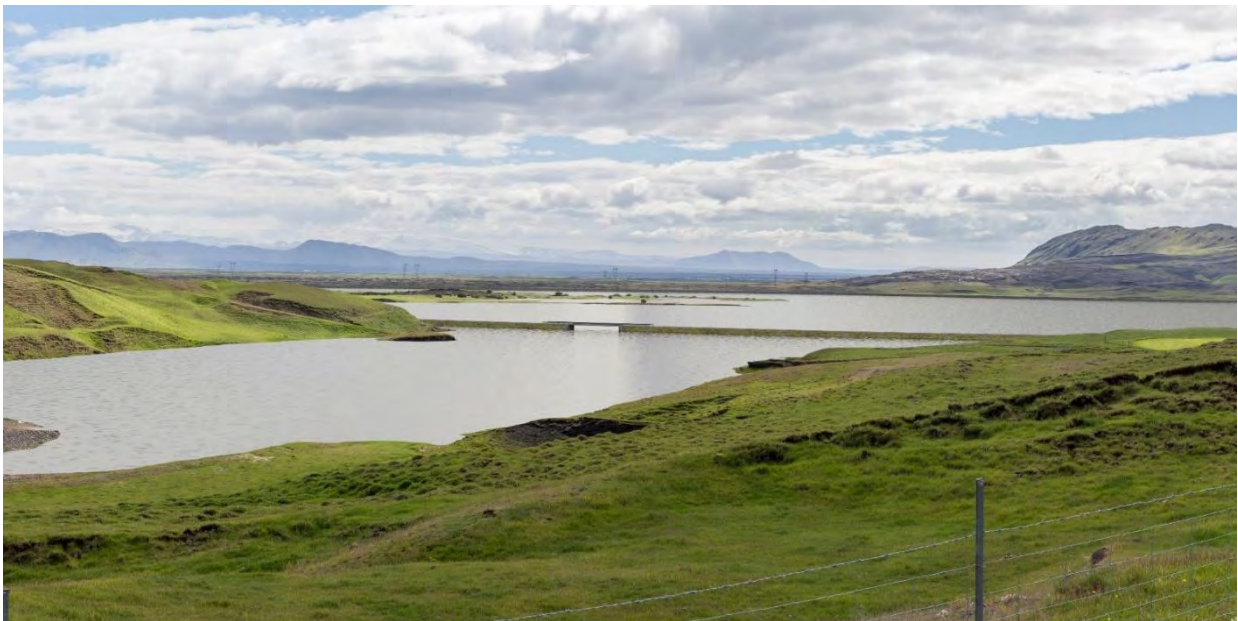
MYND 5.34 Sjónarhorn 7. Sumar. Horft til suðausturs frá Gnúpverjavegi, neðan við Fossnes – eftir framkvæmd.
