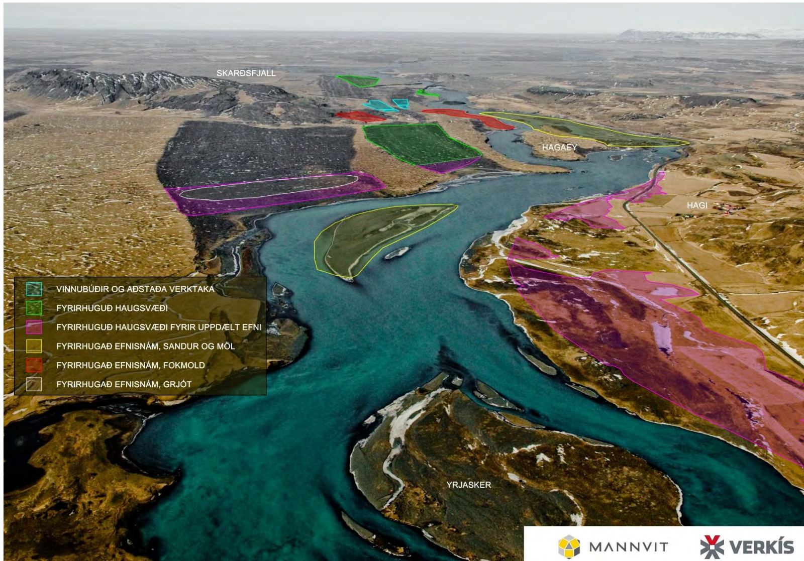
MYND 2.13 Horft í suður yfir framkvæmdasvæðið. Myndin sýnir efnistökusvæði, haugsetningu, vinnubúðir og aðstöðu verktaka.
