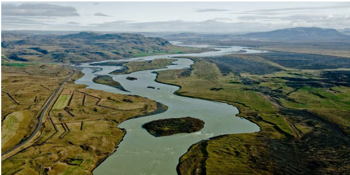
MYND 2.1 Þjórsá – yfirlitsmynd. Horft í átt að fyrirhuguðu stíflustæði og inntaksskurði.
