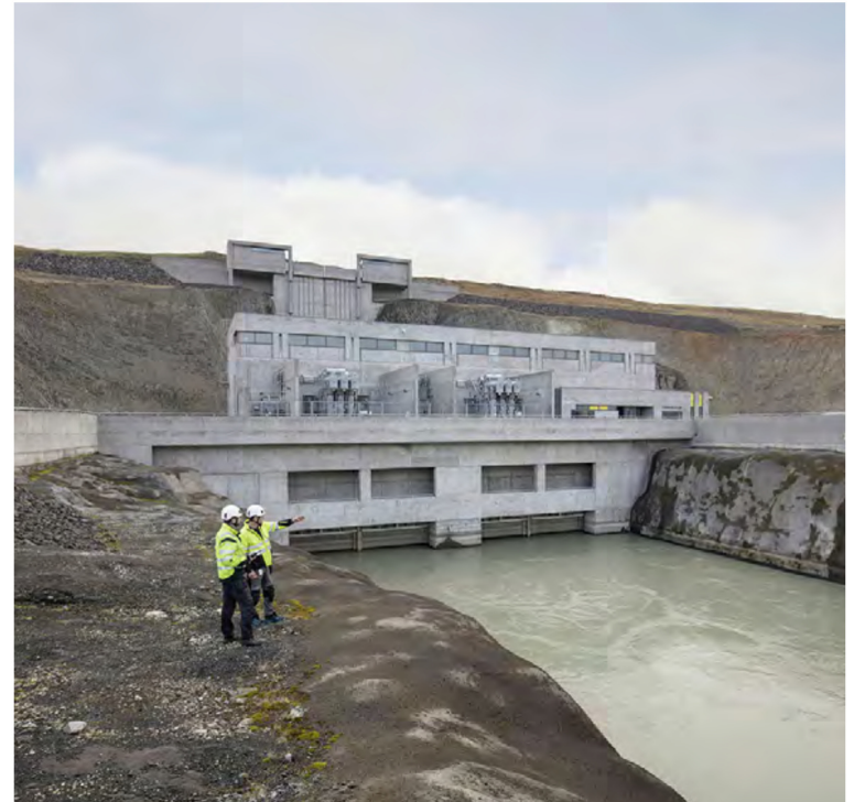
Búrfellslundur er áætlaður á stærsta vinnslusvæði Landsvirkjunar þar sem þegar eru sjö vatnsaflsstöðvar í rekstri. Búðarhálsstöð er ein þeirra, en hún er aðeins örfáa kílómetra í burtu.
