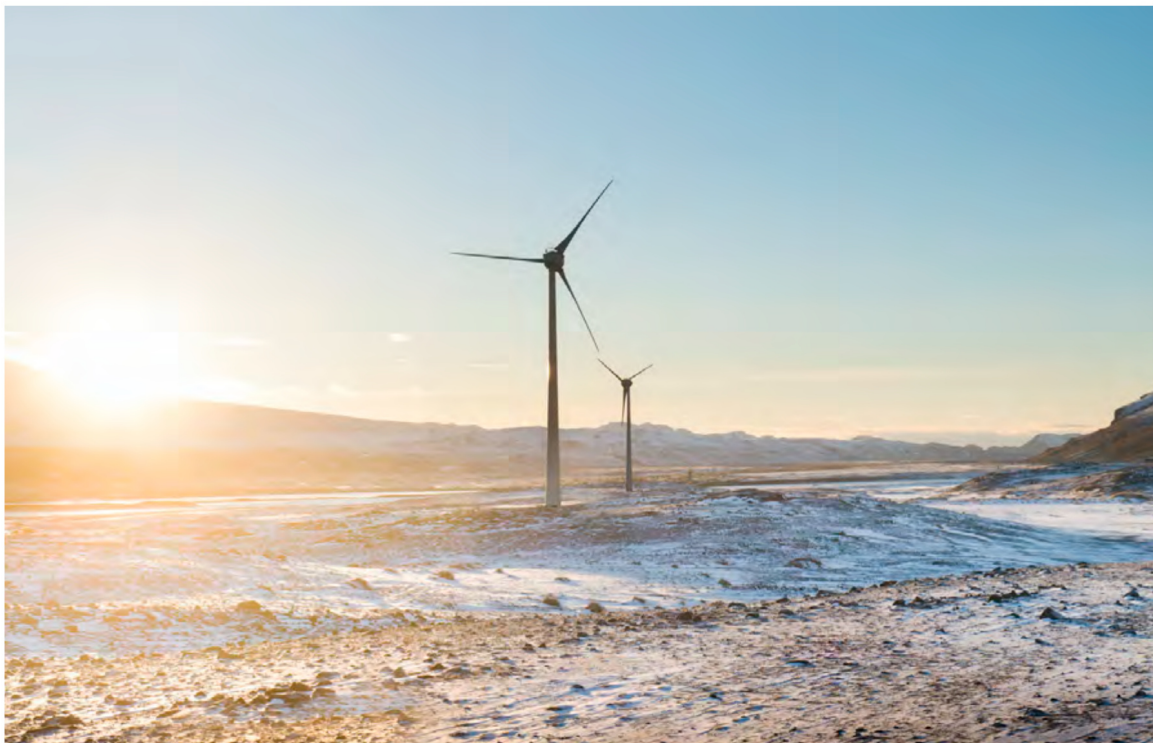
Landsvirkjun hóf tilraunaverkefni með tveimur vindmyllum norðan Búrfells árið 2013. Þær eru 77 metrar í hæstu stöðu, en áætlaðar vindmyllur í Búrfellslundi verða allt að 150 metra háar.
